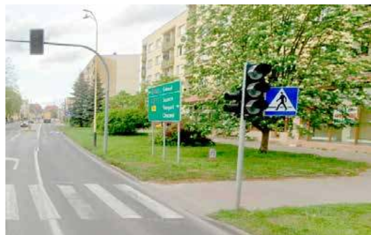
Sygnalizacja nie działa już ponad miesiąc
