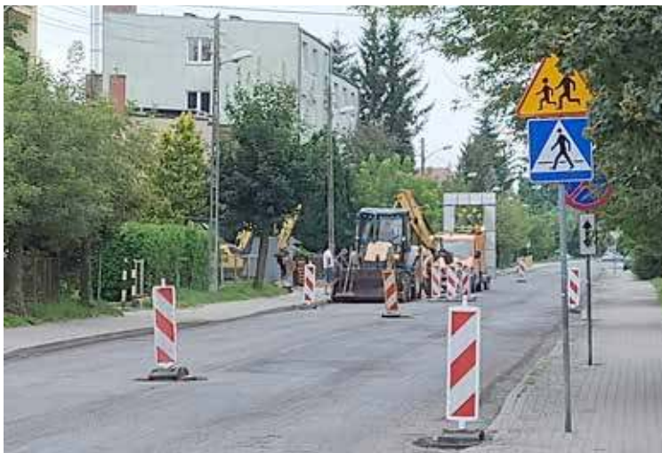
Prace na ul. ks. J. Poniatowskiego odbywają się od poprzedniego tygodnia. Zakończenie przewidziane jest najpóźniej w październiku
