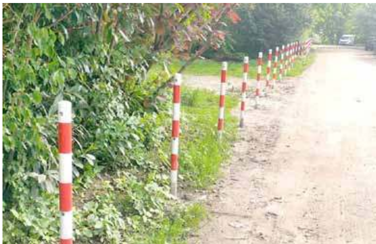
Na ul. Jeziornej w Morzyczynie pojawiło się 80 słupków, w ramach zakazu parkowania w tym miejscu oraz umożliwienia przejazdu okolicznym mieszkańcom. Zdjęcie Stowarzyszenie Kobylanka gminą dla swoich mieszkańców
