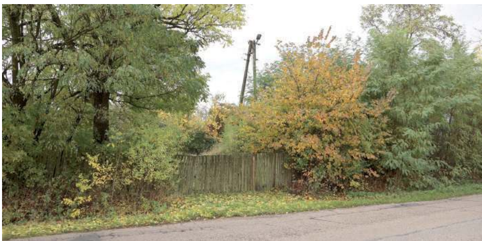
Słup z latarnią stoi oddalony od drogi. Choć po zmroku jest włączona, to na jezdnię w miejscowości Rudzienko pada jedynie kilka smug światła. Mieszkańcy apelują do gminy o wycięcie zieleni, która wpływa na jakość oświetlenia
