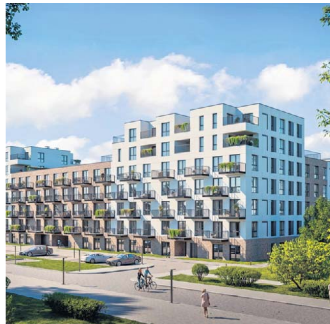
Hipoteczna Park - dwa budynki z 204 lokalami o zróżnicowanych metrażach (od 32 do 106 mkw.) i prywatnym parkiem
