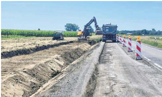
Trwa remont drogi krajowej nr 60 z Topoli Królewskiej (powiat łęczycki) do Kutna. Prace potrwać do 2028 roku
