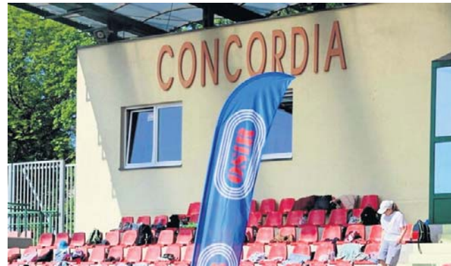
Obiekty piotrkowskiego Ośrodka Sportu i Rekreacji przeszły konieczną modernizację, podnoszącą ich standard
