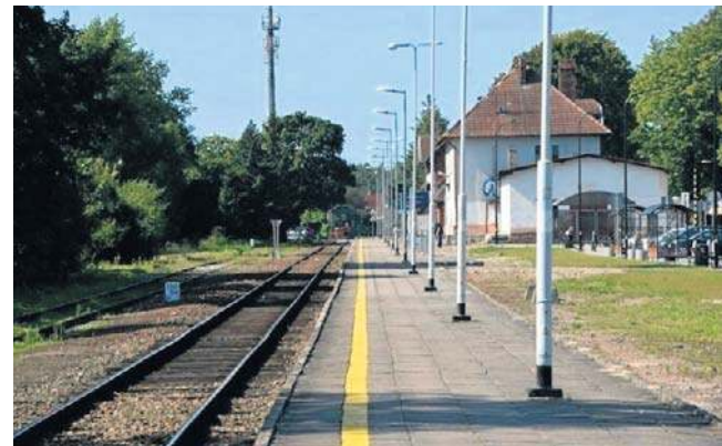
Firma Torpol zmodernizuje linię do Łeby i Słajszewa
