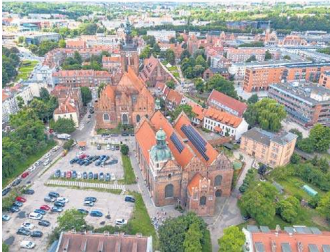
Panele fotowoltaiczne zostały zainstalowane na dachu bazyliki św. Brygidy w maju 2023 roku
