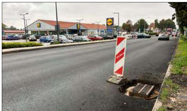
Pod ziemią znaleziono kilka odcinków sieci wodociągowej powstałej na początku XX wieku.
