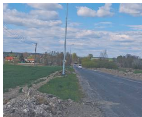
Wola Siennicka - modernizacja oświetlenia ulicznego.
