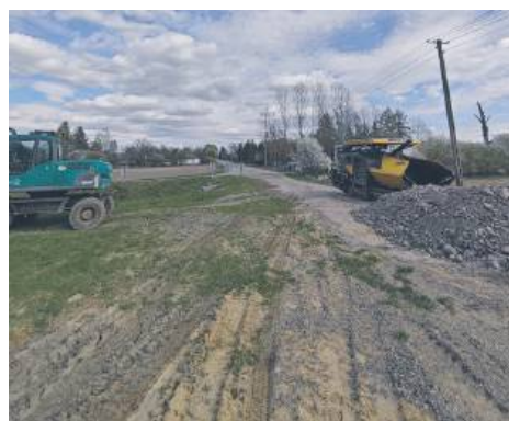
Wola Siennicka - przebudowa drogi -
