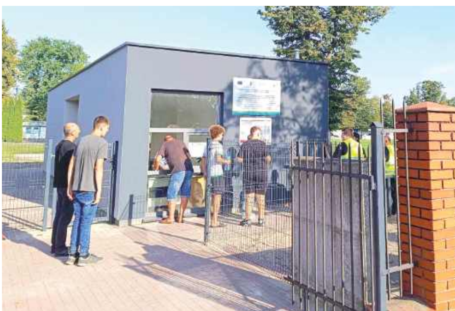
Do budowy przez Orlęta nowego pawilonu sanitarnego przyczyniły się fundusze pozyskane z Urzędu Marszałkowskiego w Lublinie za pośrednictwem LGD Zapiecek
