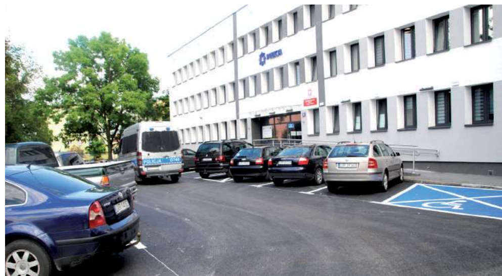
Modernizacja parkingu przy Komendzie Powiatowej Policji w Opolu Lubelskim pochłonęła w sumie około 35 tys. zł. Prace sfinansowane zostały ze środków przekazanych przez powiat opolski i Komendę Wojewódzką Policji w Lublinie
