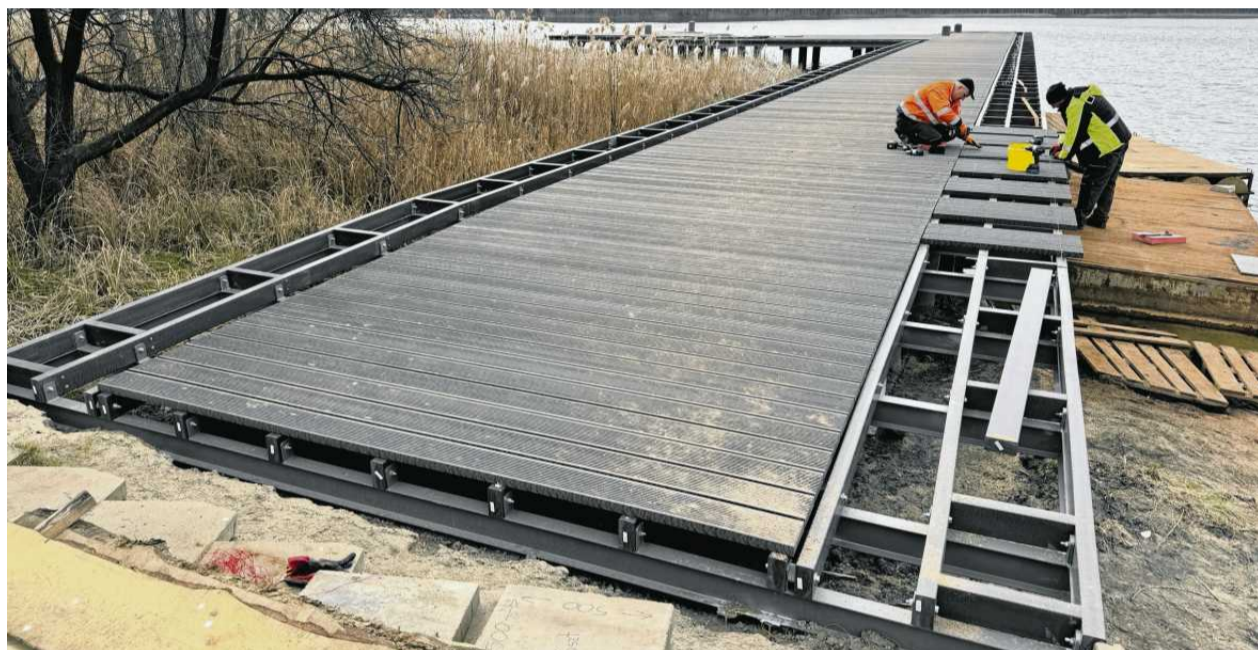
• Odbudowany pomost w Strzeszynie ma być gotowy do końca maja
