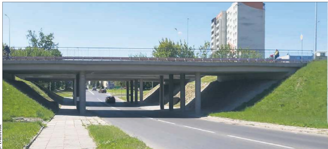
Wiadukt nad ulicą Spółdzielczą
