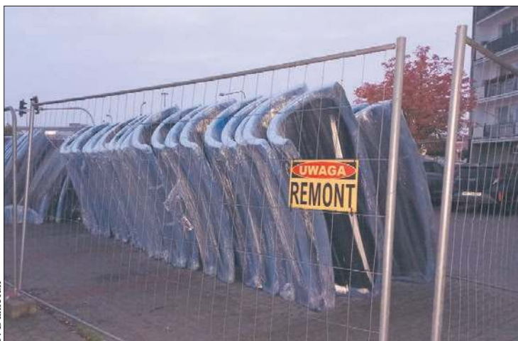
Część basenowa Podolanki ma zostać oddana do użytku w połowie grudnia. Montaż zjeżdżalni może potrwać nawet do marca przyszłego roku
