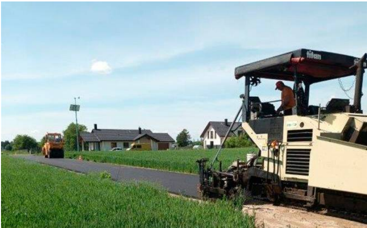
Ul. Barwna, to jedna z dróg wykonanych w ramach II etapu programu remontu gruntówek
