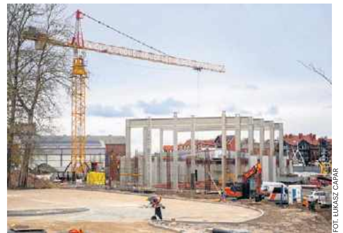
Budowa bazy w Ustce dla morskiej farmy wiatrowej
