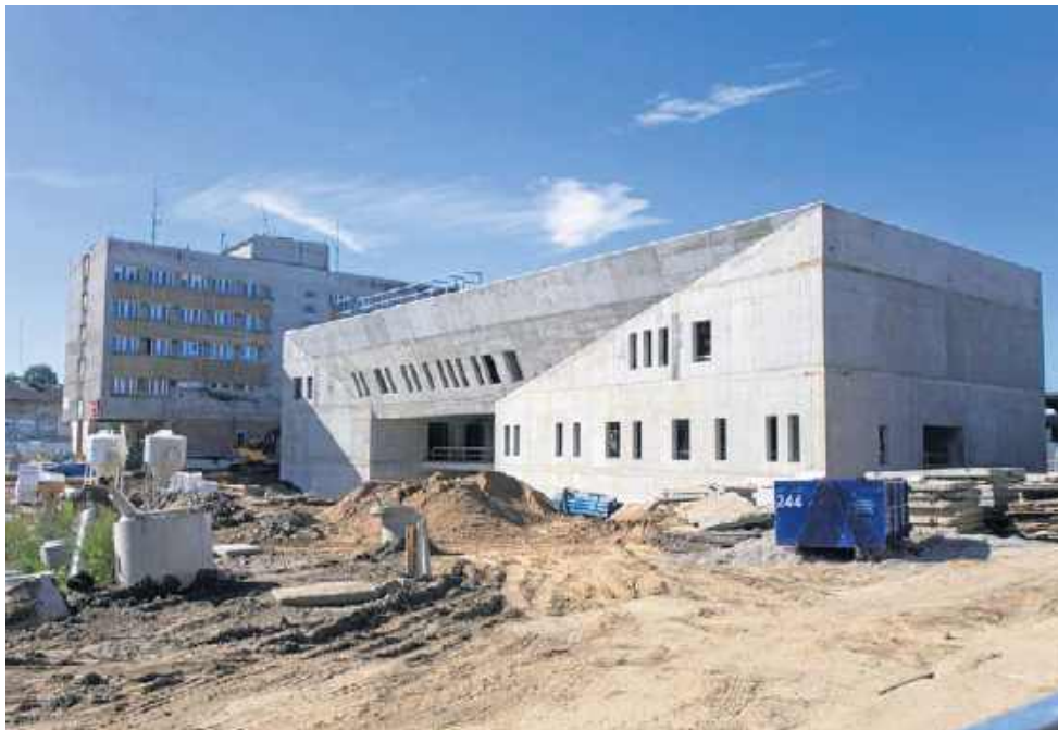
Budowa nowego dworca kolejowego w Słupsku
