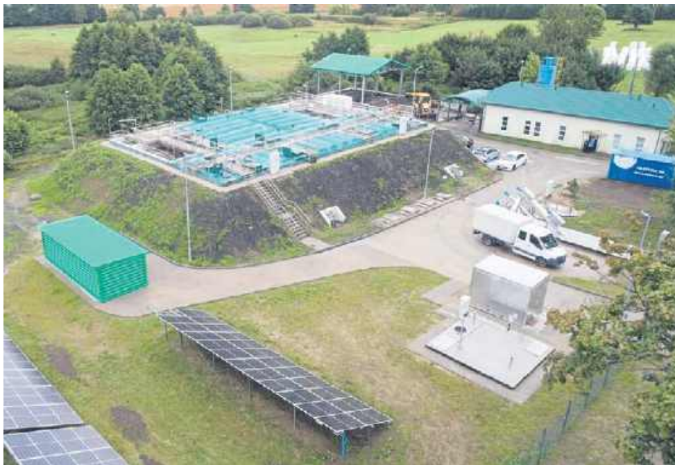
Oczyszczona woda z oczyszczalni w Główczych wpada do Strugi Główczyckiej
