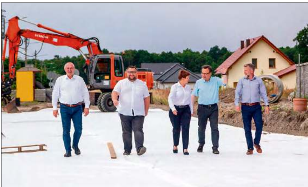
Na placu budowy w Gwoźdźicach odbyła się wizytacja.
