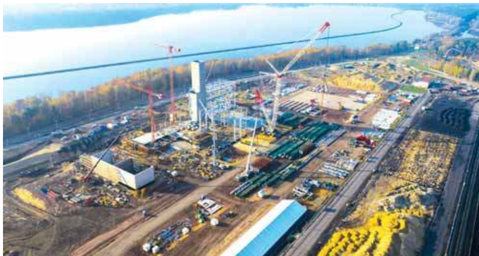
Nowo budowany blok gazowo-parowy w Rybniku
