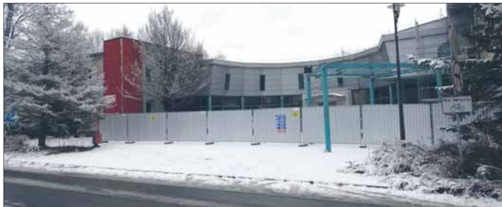
Remont przyszłego budynku Akademii WSB
