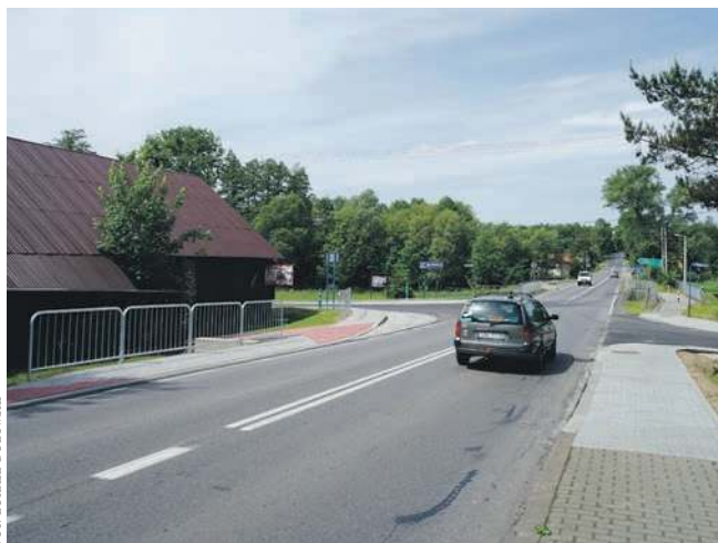
Pomysł na lokalizację przejścia dla pieszych na Mickiewicza, w sąsiedztwie połączenia z Krasickiego i Sienkiewicza, okazał się nietrafiony
