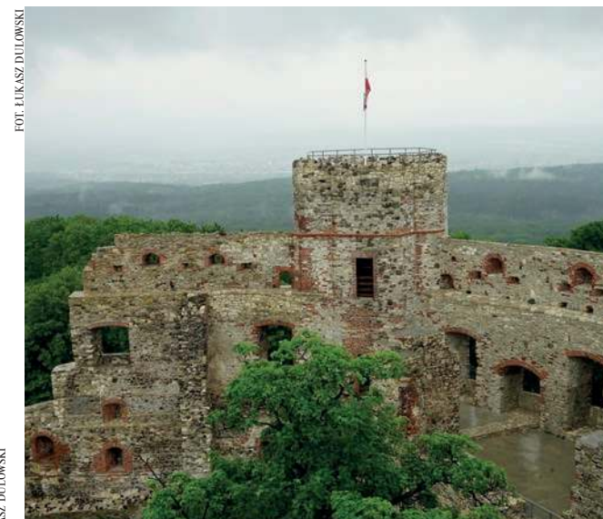
Na wyremontowanej Baszcie Dorotce zamontowano platformę widokową. Obiekt muszą jeszcze tylko odebrać odpowiednie służby i turyści będą mogli oglądać z góry cudowne panoramy rozciągające się na cztery strony świata
