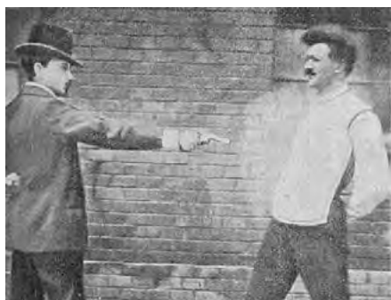
Fotografia 13, 14, 15. Test kamizelki kuloodpornej autorstwa Jana Szczepanika. Na zdjęciu dostępnym w Internecie utrwalono moment, kiedy testujący ekspert z odległości trzech kroków strzelał z rewolweru o kalibrze 7 mm do ubranego w kamizelkę służącego Szczepanika – który wyszedł z tej próby bez szwanku. Uczestników tej próby fakt „podstawienia” służącego ani nie gorszył, ani nie dziwił, a prasa rozpisywała się o „kuloodpornym lokajuju”.
