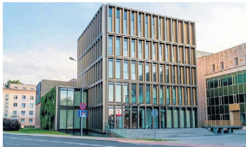
Zakończyła się budowa nowej siedziby radomskiego „Medyka”. Jest tu między innymi zielona ściana i taras na dachu.
