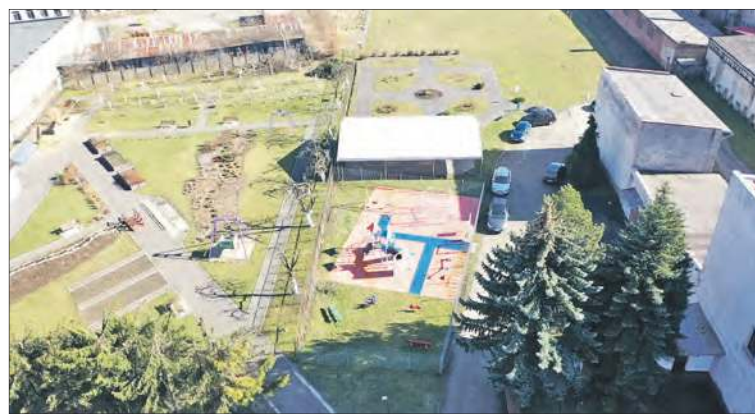
Teren SOSW, w głębi plac pod przyszłe boisko wielofunkcyjne
