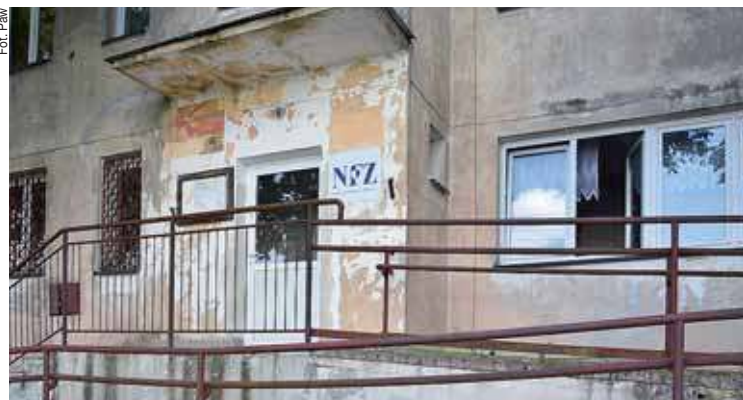
Budynek gdzie znajdował się będzie ośrodek zdrowia
