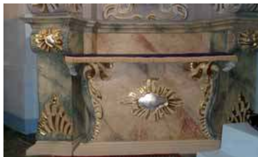
Postument i mensa z odsłoniętą pierwotną malaturą
