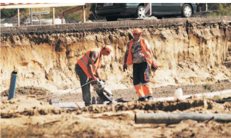
Prace na odcinku od węzła Rudnik nad Sanem do węzła Nisko Południe. Wykonawca zapewnia, że już niebawem znikną utrudnienia w ruchu na drodze krajowej nr 77
