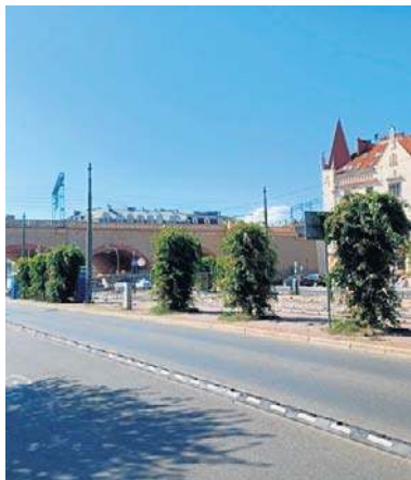
Postępują prace związane z modernizacją torowiska
