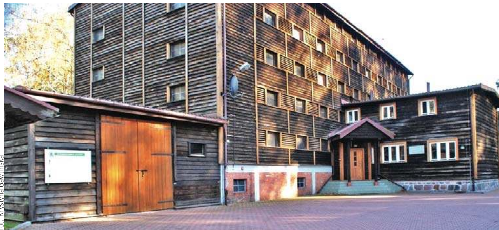
Wyluszcarnia składa się z kompleksu zabytkowych budynków murowanych i drewnianych
