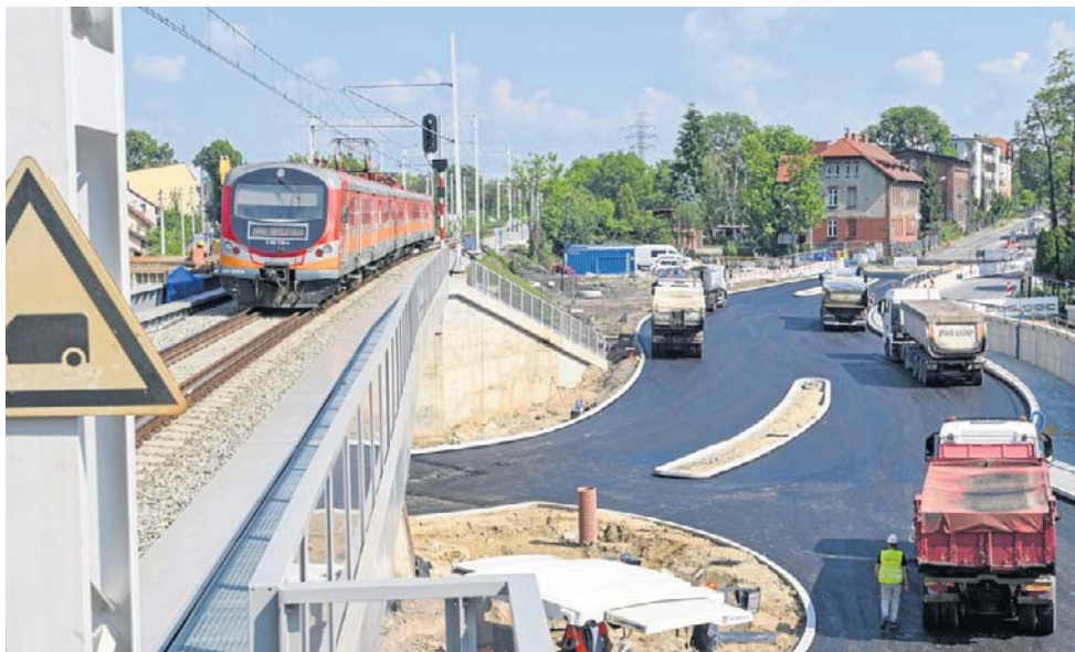
Wielka inwestycja za pół miliarda złotych w Gliwicach-Łabędach przekroczyła półmetek
