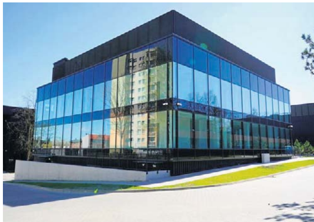
Zmodernizowana siedziba Archiwum Państwowego w Katowicach oddana do użytku
