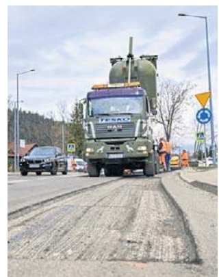
Frezowanie asfaltu powoduje utrudnienia w ruchu
