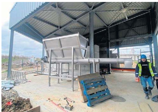
Na terenie oczyszczalni ścieków w Tuchowie trwa budowa instalacji do przetwarzania odpadów
