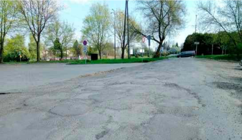
Już wkrótce na ul. Mackiewicza pojawi się nowy asfalt
