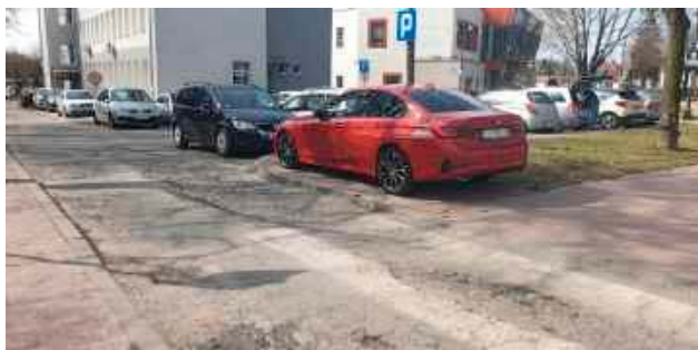
Oprócz samego parkingu wyremontowany i poszerzony zostanie wjazd od ul. Niepodległości
