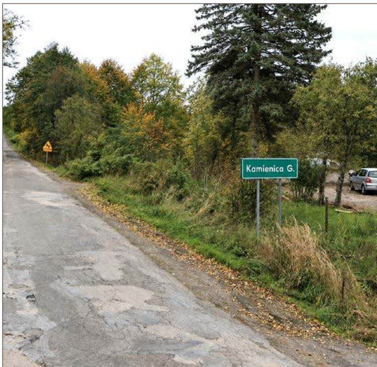
Najdłuższy odcinek zaplanowany do remontu znajduje się w Kamienicy Górnej.
