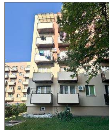
Na bloku przy Łysogórskiej 19 balkony już zamontowane.
