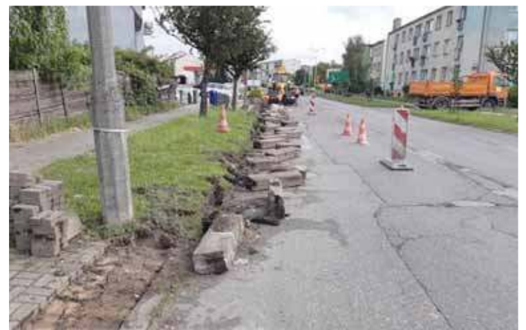
Wymiana krawężników na ul. Grzebskiego
