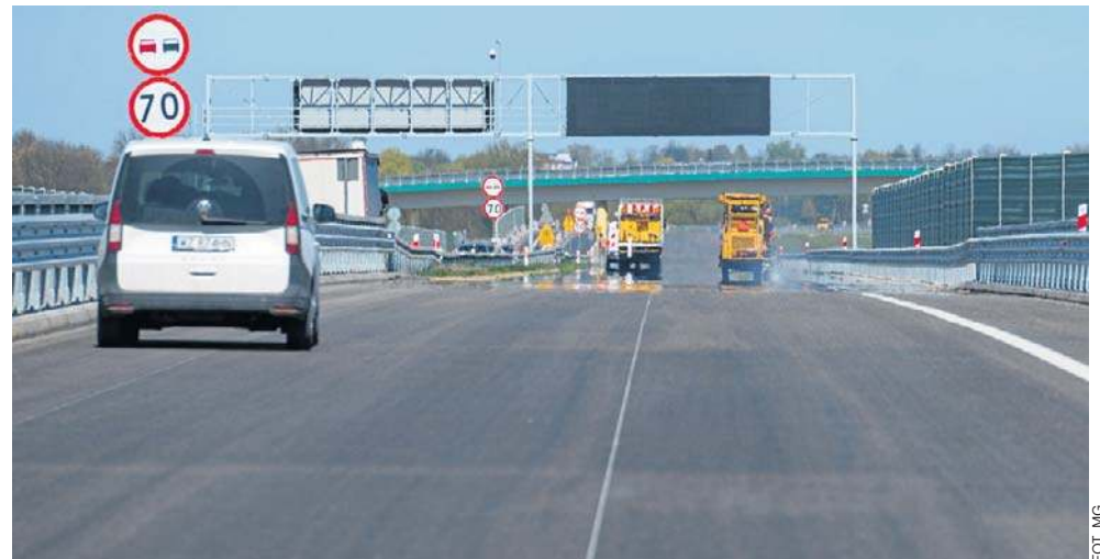
W tej chwili na S19 pod Kockiem trwają prace wykończeniowe, malowane jest oznakowanie poziome
