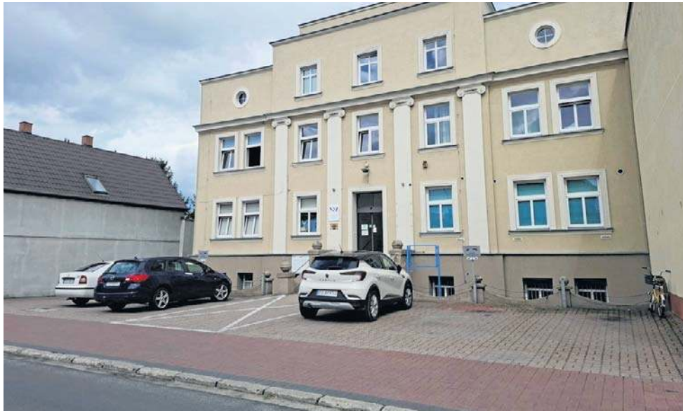
Wykonawca ma przygotować plan modernizacji budynku tak, aby zmieściły się w nim trzy jednostki
