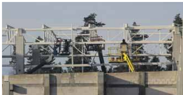
Na budowie Color Parku można dostrzec kilku robotników montujących stalowe konstrukcje stropów.
