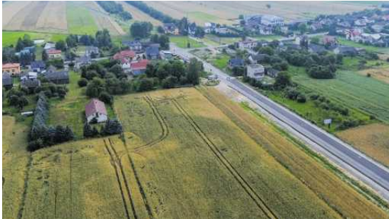
Tychów Stary – początek remontowanego odcinka
