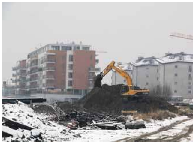
Rozpoczęły się pierwsze prace przy budowie bloku w ramach programu Mieszkanie Plus.
