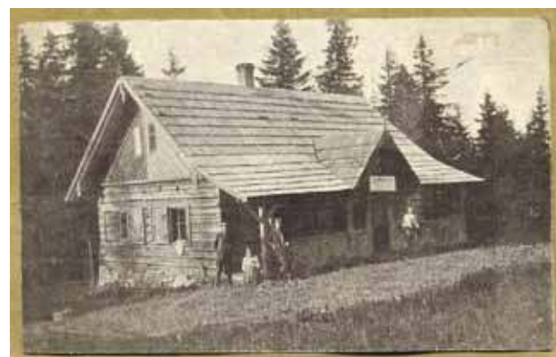
W skansenie zostanie odbudowane schronisko z 1906 r.
