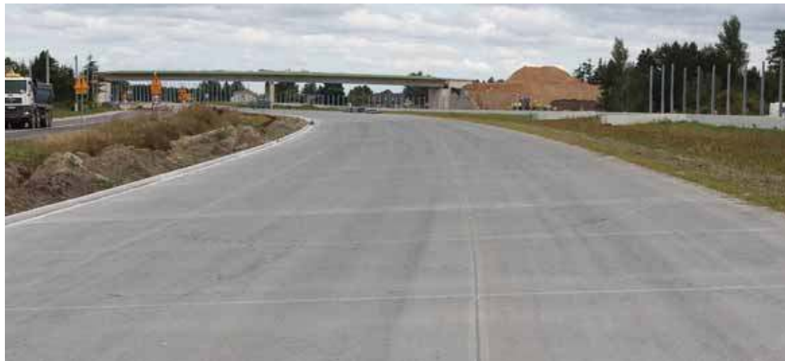
Betonowa nawierzchnia jest wytrzymalsza, ale głośniejsza niż nawierzchnia asfaltowa
