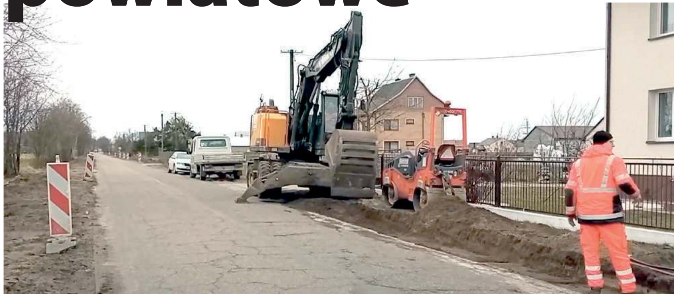
Remont drogi powiatowej w Soinach w gminie Wola Mysłowska
