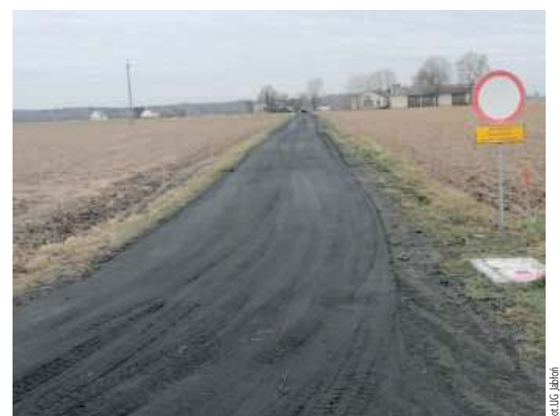
Droga gminna nr 103788L w trakcie budowy
