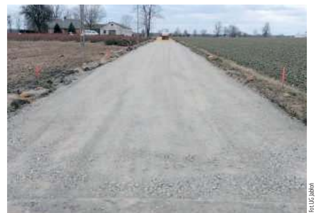
Trwa budowa drogi gminnej nr 103788L
