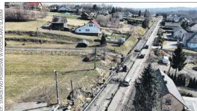
■ Droga powiatowa nr 5021S w przebudowie.
