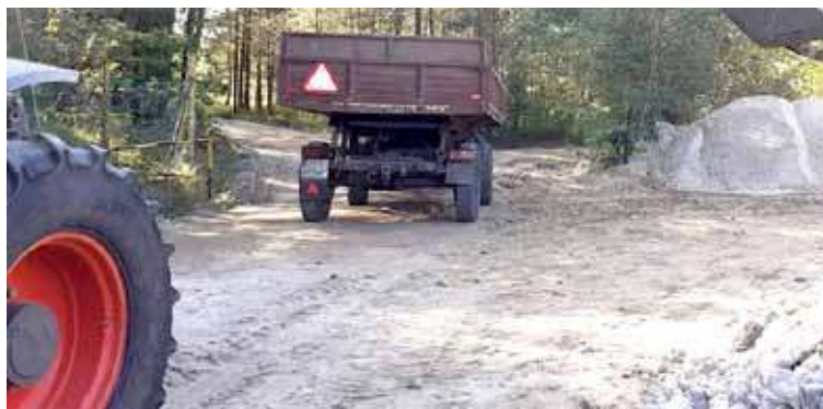
Do wyrównywania kolein i nierówności wykorzystano 500 ton materiału
