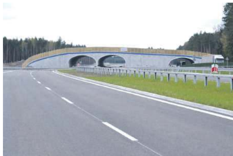
W ciągu odcinka Zdziary – Rudnik powstało kilka obiektów, w tym przejście dla zwierząt
