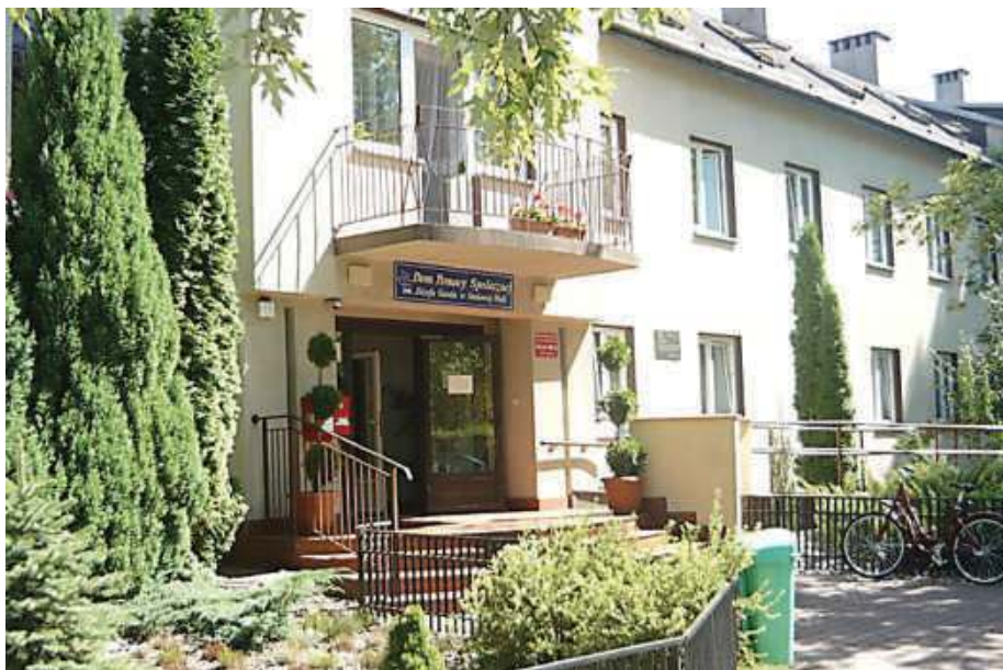
Dom Pomocy Społecznej im. Józefa Gawła w Stalowej Woli przejdzie modernizację energetyczną
