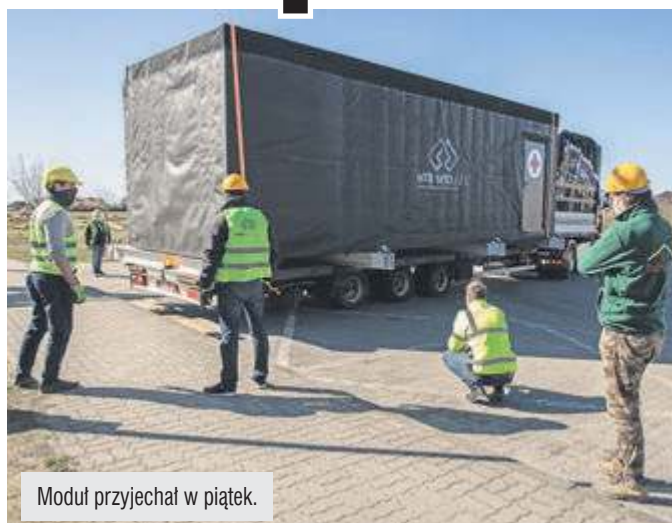
Pracownicy postawili połowę izby przyjęć przy podjeździe dla karetek.
