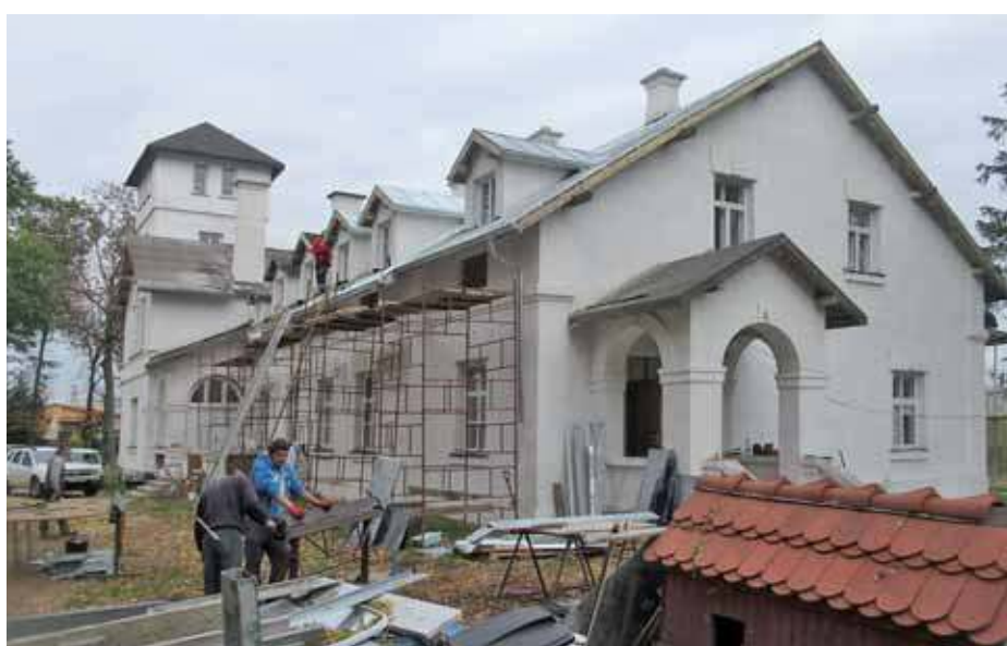
Właściciele już naprawiają dach
