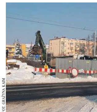
Roboty przy wiadukcie na 29 Listopada w Chrzanowie
