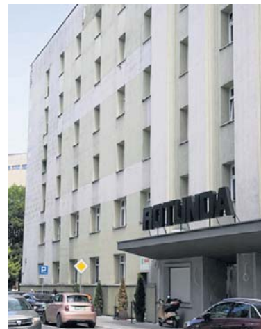
W Centrum Kultury Rotunda trwa wielki remont
