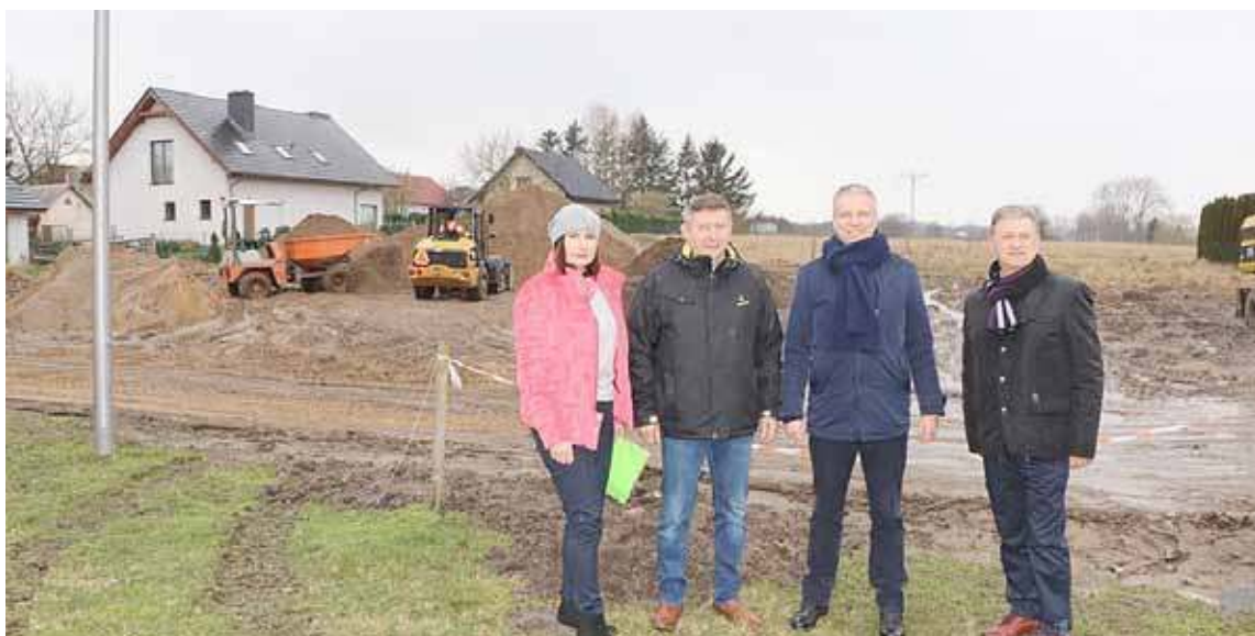
Na Topolowej wykonano już część prac
