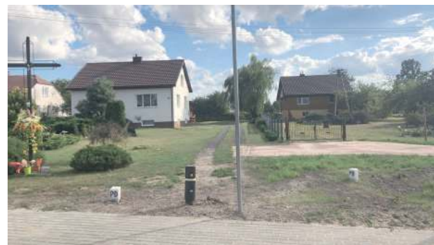
Do posesji państwa Sobieckich (po lewej) prowadzi wspólny podjazd z sąsiadami. Podjazd łączy się z drogą wjazdową pod kątem 90 stopni, co bardzo utrudnia wjazd, szczególnie dla maszyn rolniczych i aut dostawczych
