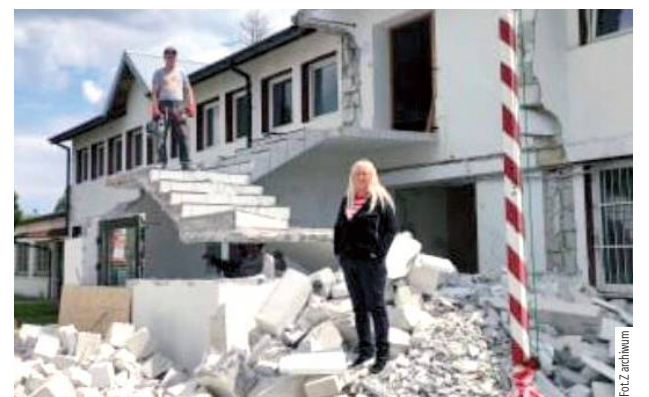
W 2021 roku termomodernizację przeszła siedziba Urzędu Gminy
