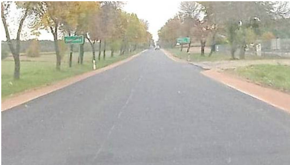
DW 815 po remoncie, przed malowaniem pasów
