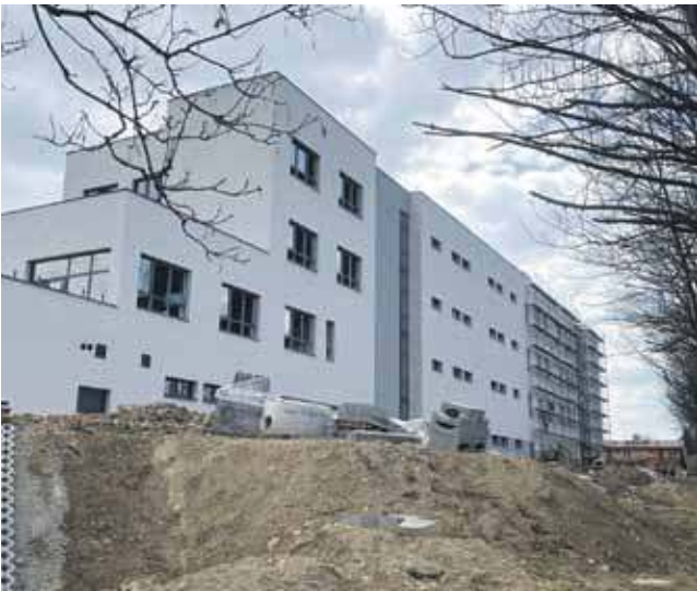
Z zewnątrz budynek wygląda na gotowy.
